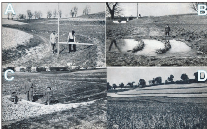
Ryc. 4. Melioracje przeciwoerozyjne w obrębie suchych dolin: A - zadarnienie pasa dna suchej doliny, Sławin (Ziemnicki 1951), B - kieszki faszynowe, zmniejszające prędkość spływającej wody, Sławin (Ziemnicki 1949), C - przegroda kamienna w osi spływu, Sławin (Ziemnicki 1949), D - pola wstęgowe na sterysowanym zboczu doliny, Sławin (Ziemnicki 1951)
