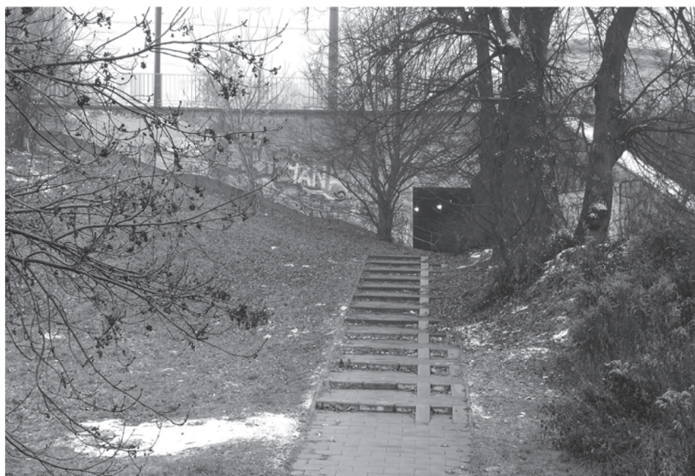
Ryc. 1. Przykład istniejącej infrastruktury mogącej stać się częścią Zielonej Sieci po renowacji i likwidacji barier (podjazd zamiast schodów). Przejście podziemne pod ul. Orkana.
